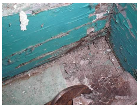
Matériaux : ZPSO-S05 Prélèvement : P159 Description : Dalle de sol 22*22 verte et colle noire sous lés souples Localisation : RdC - 037; RdC - 039 Résultat : Présence d'amiante Quantité : 60
