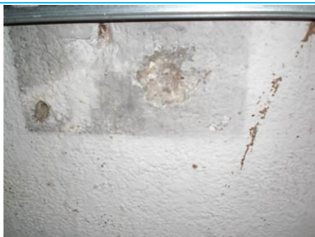
Matériaux : ZPSO-M14 Prélèvement : P166 Description : Enduit ciment refend cloison Localisation : RdC - 002 Résultat : Absence d'amiante
