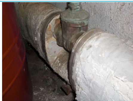
Matériaux : ZPSO-D03 Prélèvement : P168; P169 Description : Enveloppe plâtre et calorifuge laine minérale Localisation : RdC - 002 Résultat : Absence d'amiante
