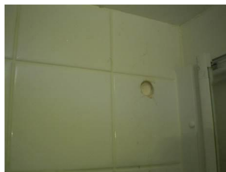
Matériaux : ZPSO-F01 Prélèvement : P107; P108 Description : Colle de faïence 15*15 blanche Localisation : RdC - 034; RdC - 010; RdC - 003; RdC - 009; RdC - 033 Résultat : Absence d'amiante Quantité :
