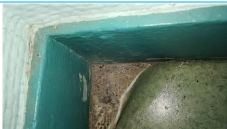
Matériaux : ZPSO-S01 Prélèvement : P154 Description : Colle noire sous lés souples Localisation : RdC - 015 Résultat : Présence d'amiante Quantité : 11ml
