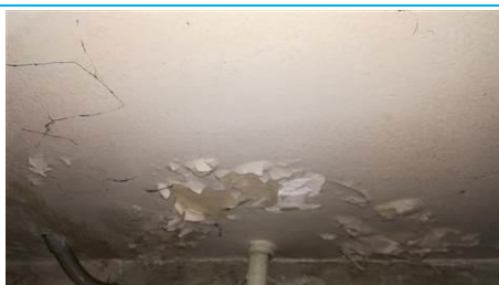
Matériaux : ZPSO-PI1 Prélèvement : P156; P160 Description : Enduit plâtre sous plafond Localisation : RdC - 015; RdC - 014; RdC - 042; RdC - 041; RdC - 037; RdC - 038; RdC - 011; RdC - 034; RdC - 010; RdC - 007; RdC - 006; RdC - 036; RdC - 003; RdC - 036b; RdC - 001; RdC - 004; RdC - 005; RdC - 008; RdC - 009; RdC - 033; RdC - 012; RdC - 013; RdC - 018; RdC - 039; RdC - 019; RdC - 031; RdC - 022; RdC - 023; RdC - 026; RdC - 030; RdC - 027; RdC - 028; RdC - 029; RdC - 025; RdC - 024; RdC - 021; RdC - 020; RdC - 017; RdC - 040; RdC - 016 Résultat : Absence d'amiante Quantité :
