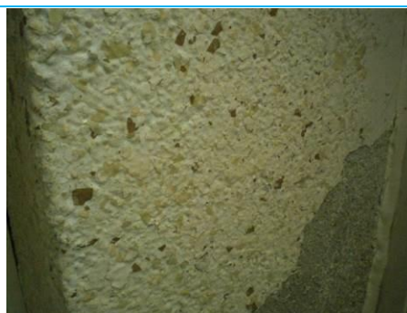
Matériaux : ZPSO-M01 Prélèvement : P158; P162 Description : Peinture pailletée blanc crème Localisation : RdC - 037; RdC - 039 Résultat : Absence d'amiante Quantité :
