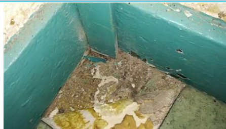
Matériaux : ZPSO-S12 Prélèvement : P148 Description : Dalle de sol 22*22 verte, ragréage et colle noire sous lés souples Localisation : R1 - 035; R1 - 030 Résultat : Présence d'amiante Quantité : 60
