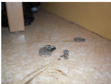
Matériaux : ZPSO-S03 Prélèvement : P105; P113; P121; P101 Description : Dalle de sol 22*22 verte, colle noire et ragréage sous dalle souple 50*50 Localisation : RdC - 011; RdC - 007; RdC - 006; RdC - 036; RdC - 036b; RdC - 001; RdC - 005; RdC - 008; RdC - 012; RdC - 018; RdC - 022; RdC - 021; RdC - 017 Résultat : Présence d'amiante Quantité : 175
