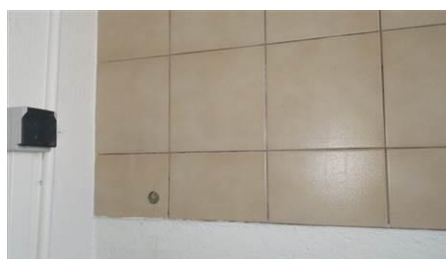
Matériaux : ZPSO-F04 Prélèvement : P153 Description : Colle de faïence 20*20 crème Localisation : R1 - 014 Résultat : Absence d'amiante Quantité :
