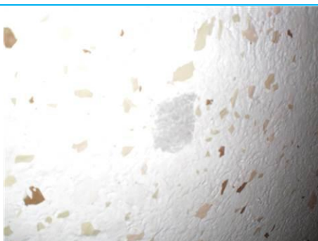
Matériaux : ZPSO-M01 Prélèvement : P158; P162 Description : Peinture pailletée blanc crème Localisation : RdC - 037; RdC - 039 Résultat : Absence d'amiante Quantité :
