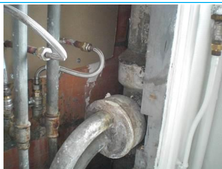
Matériaux : ZPSO-D02 Prélèvement : P172 Description : Conduit EU en fibres-ciment Localisation : R1 - 004; R1 - 019 Résultat : Présence d'amiante
