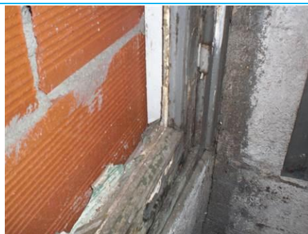
Matériaux : ZPSO-D05 Prélèvement : P171 Description : Mastic de vitrage sur châssis intérieur muré Localisation : RdC - 002 Résultat : Absence d'amiante
